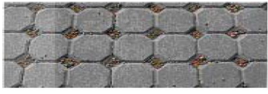
ריצוף מחלחל, תחת הריצוף מוצע לבצע אוגר למים ממולא חצץ ועטוף בריעה גיאוטכנית.
