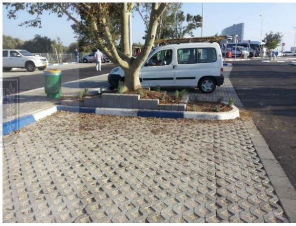
חנייה מריצוף חדיר בכביש 6. תחת הריצוף מומלץ אוגר למים ממולא חצץ ועטוף בריעה גיאואסינטטית
