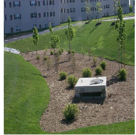
מתקן קליטת נגר ממפלס מוגבה, לשיפור פעולת ההשהיה בשצ"פים.
